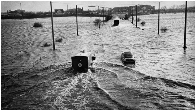
Hamburger Sturmflut 1962: Einsatzfahrzeug des Roten Kreuzes durchquert überfluteten Stadtteil Foto: DRK
